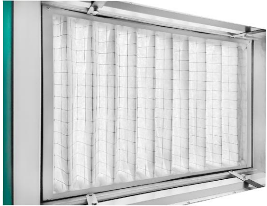
Рисунок 17 (б) Загальний вигляд касетного фільтру в секції
